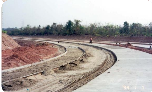
ก่อสร้างถนนสายหลักในวิทยาเขตหนองคาย
